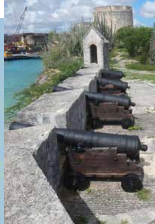
Consolidatie Kanonnenbatterij bij Fort Beekenburg (C)
