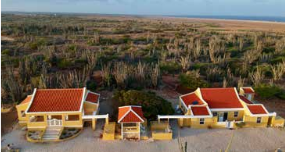
Foto onder Stg. Rooi Lamoenchi Kunuku Park: Restauratie slavenmuur (B)
